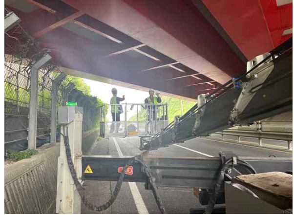
고소차를 이용한 근접조사
